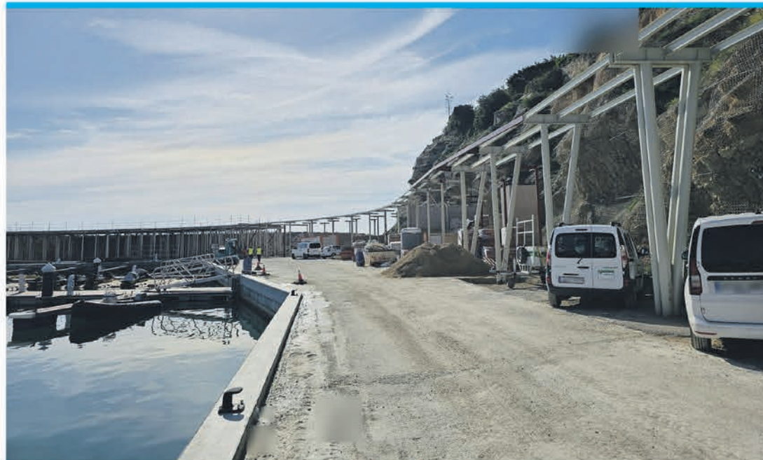
Die Bauarbeiten schreiten voran am alten Hafen Puerto Blanco.
